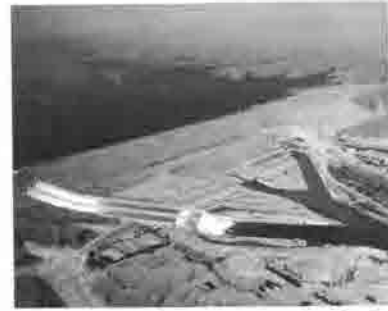
شکل ۴. نمای از سد مخزنی کرخه در اندیشک.
